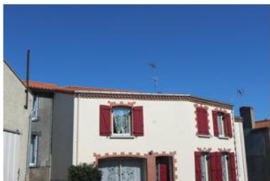
Encadrements et toiture en brique
