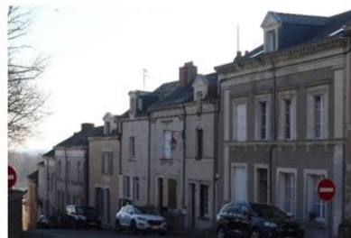
Encadrements en tuffeau et toiture en ardoise
