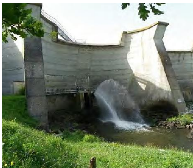
PHOTOGRAPHIE 19 Barrage du Verdon (DDRM 49)
