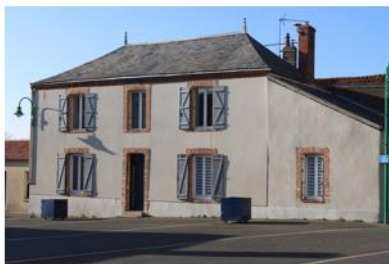
Encadrements en brique et toiture en ardoise
