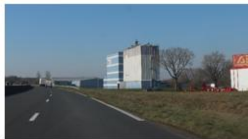
Bâtiment industriel en zone d'activité
