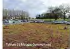
Toiture de Mauges Communauté
