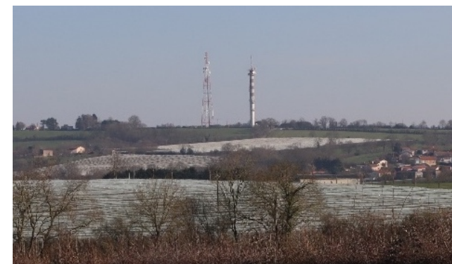
Antennes de télécommunication perceptibles dans le paysage
