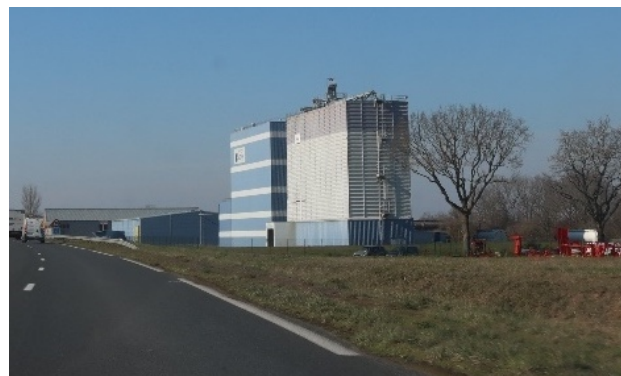
Bâtiment industriel en zone d'activité
