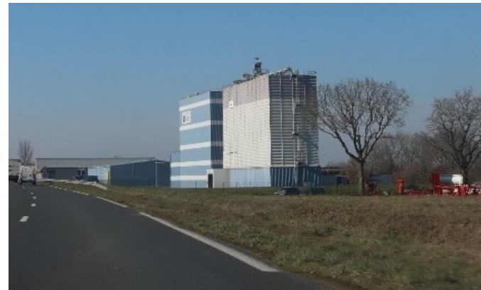
Bâtiment industriel en zone d'activité
