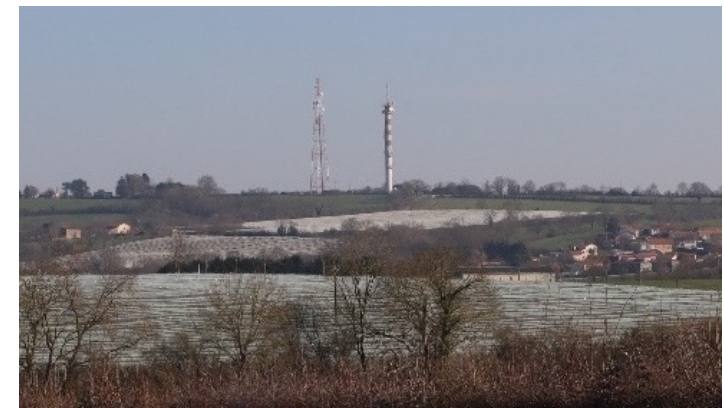
Antennes de télécommunication perceptibles dans le paysage
