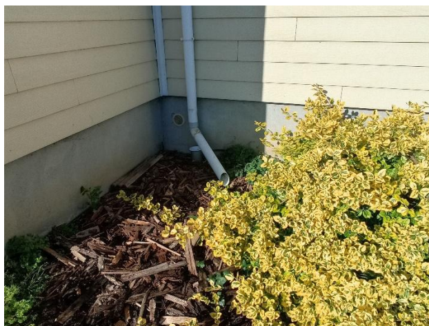
Figure 2 : Gouttière dirigée vers l'espace vert (Beaupréau-en-Mauges)
