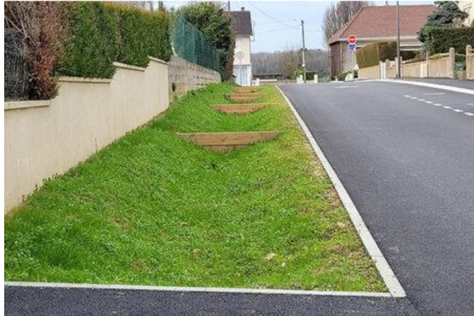
Figure 1 : Exemple de noue à redans permettant de freiner l'eau (Montrevault-sur-Evre)
