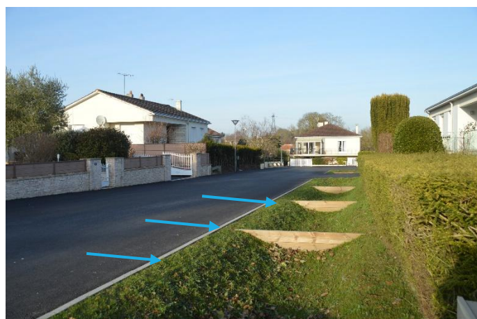
Figure 3 : Nivellement de la voirie pour un écoulement diffus vers la noue, avec alimentation diffuse (Montrevault-sur-Evre)
