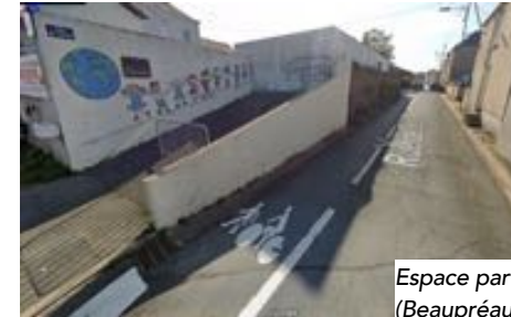
Aux abords du collège Frédéric Ozanam à Saint-Pierre-Montlimart (Montrevault-sur-Evre)
