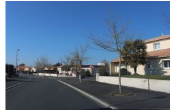
Voirie de lotissement
