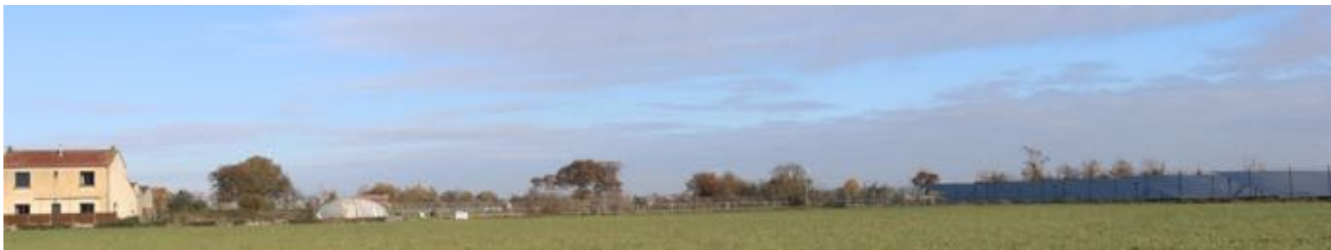
Parcelle enclavée entre le parc PV et le hameau
