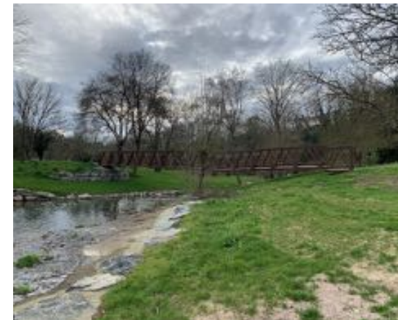
Passerelle à Raz Gué - Montrevault-sur-Evre
