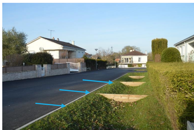
Figure 3 : Nivellement de la voirie pour un écoulement doux vers la noue, avec alimentation diffuse (Montrevault-sur-Evre)
