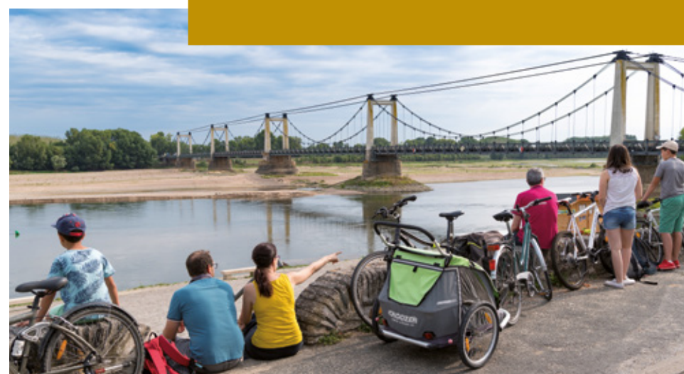
Le pont de Montjean-sur-Loire à Mauges-sur-Loire marque l'une des extrémités de la digue de Loire.
