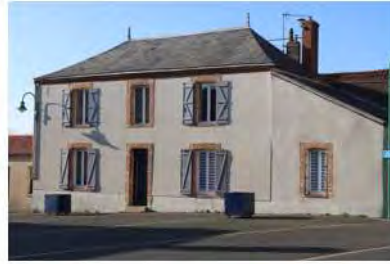
Encadrements en brique et toiture en ardoise
