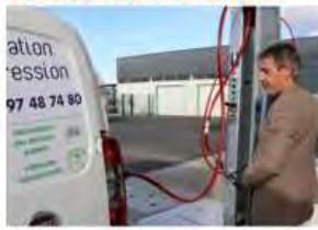
Première station biogaz produit et consommé localement 2023 La Pommeraye
