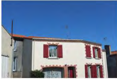
Encadrements et toiture en brique
