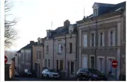
Encadrements en tuffeau et toiture en ardoise
