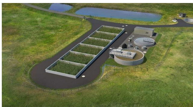
Ancienne station de lagunage et projet de la future station d'épuration à boues activées pour 1000 eq.hab.
