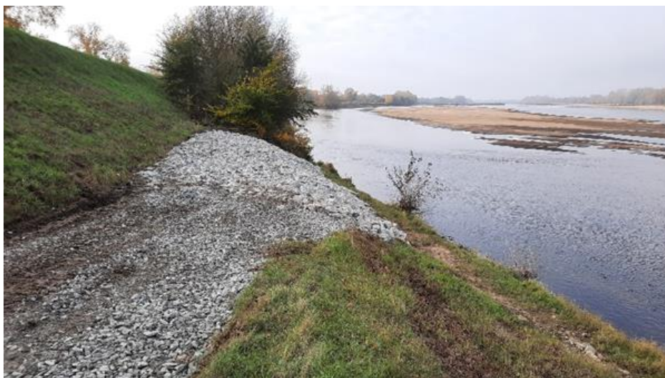
Travaux de renforcement du pied de la digue au Chêneveau, novembre 2021.
