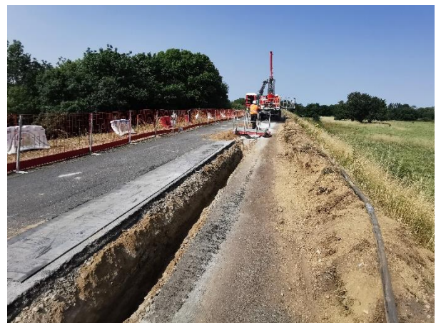
Construction d'un écran étanche à Montjean-sur-Loire
