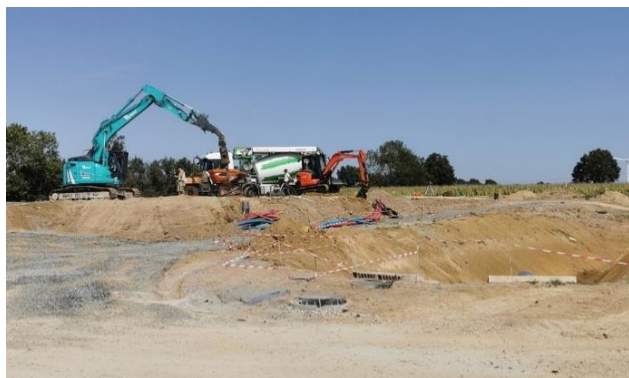
Travaux de la future déchetterie en cours à Jallais
