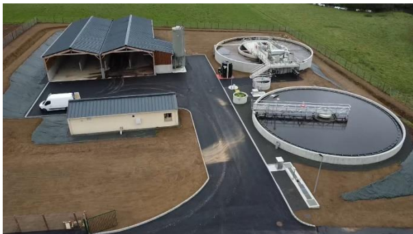
Nouvelle station d'épuration à Montfaucon-Montigné / Sèvremoine
