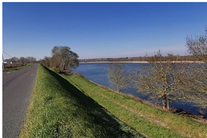
Digue entre Saint-Florent-le-Vieil et Montjean-sur-Loire
