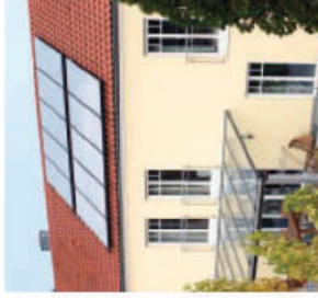
Vitosol 200-F en place sur un petit bâtiment collectif
