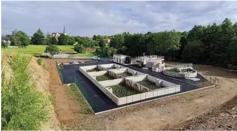
Station d'épuration à Chemillé-en-Anjou (Neuvy-en-Mauges)
