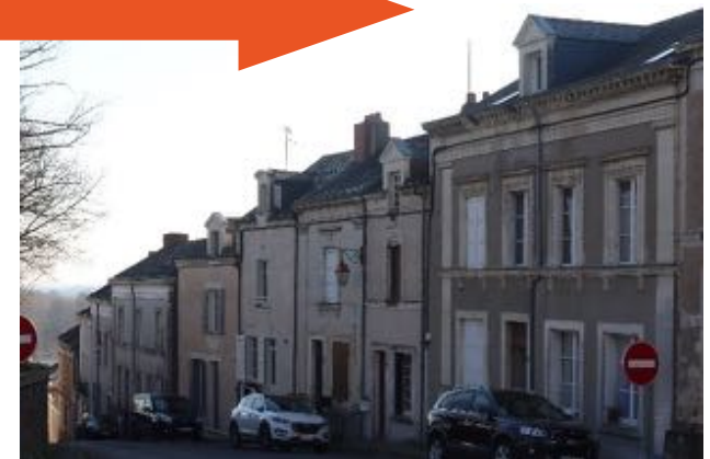
Encadrements en tuffeau et toiture en ardoise
