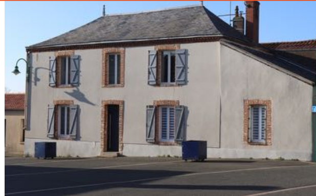
Encadrements en brique et toiture en ardoise
