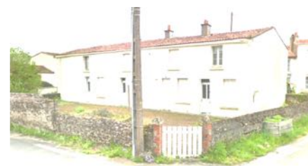
Site du projet d'un habitat partagé pour les seniors La Boissière-sur-Evre Montrevault-sur-Evre (association Habit'âge)
