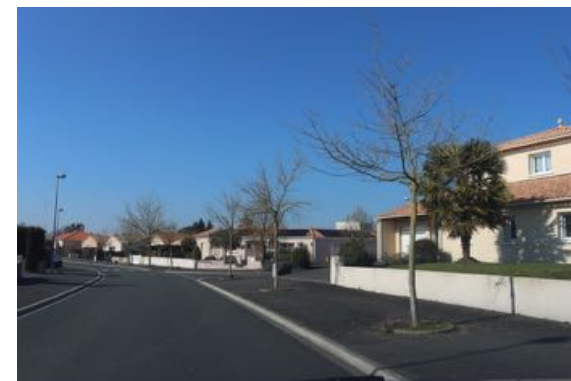
Voirie de lotissement
