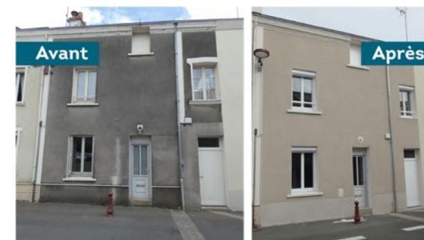
Traitement de façade en centre-ancien (OPAH)
